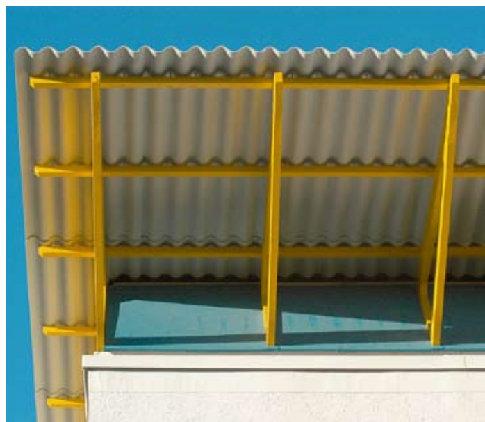
Renowacja płaskiego dachu Architekt: STÄWOG, Bremerhaven; zdjęcie: Peter Frese, Wuppertal
