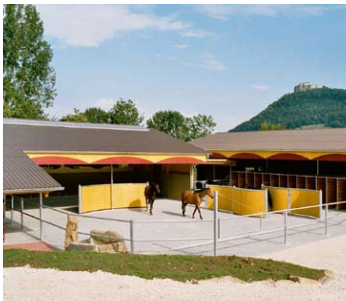
Stadnina koni Hämmerling Architekt / Zdjęcie: Schlosser Holzbau GmbH, Jagstzell
