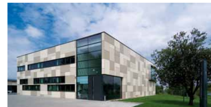
Budynek TPA, Pruszków, Polska Zdjęcie: Tomasz Sinek, Studio Mani, Tarnowskie Góry, Polska
