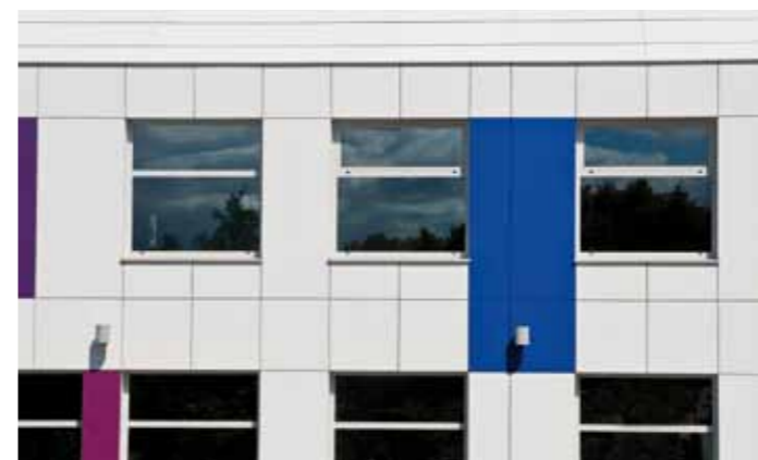
Przedszkole Fundacji BPJ, Gdańsk, Polska; Architekt: CKK Architekci, Gdańsk
